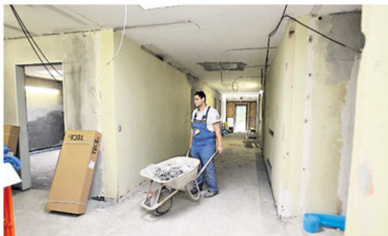
Baustelle Sporthalle: Die Arbeiten an der Halle des Humboldt-Gymnasiums gehen voran.
